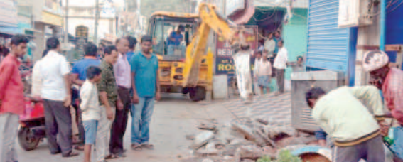
అండర్ గ్రౌండ్ కేబుల్ ఏర్పాటుకు చేపట్టిన పనులు
